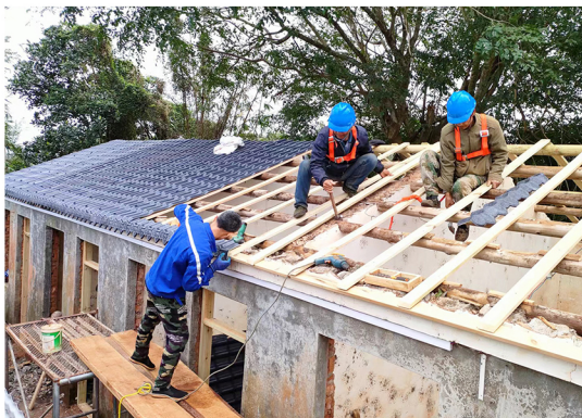
海南农场加班加点维修房屋，员工在精心更换屋顶、运输建筑材料。
